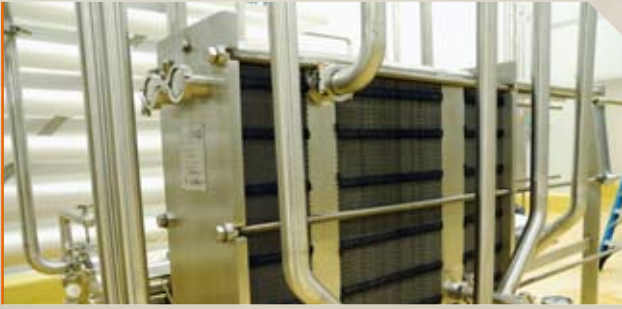
> Intercambiador de calor de placas con marco con barra de amarre
